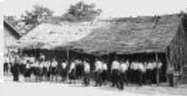
今にも崩れ落ちてきそうな校舎
